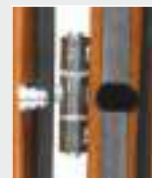
Uszczelka pečniewicząca P.POŻ. W STANDARDZIE do ościeżnicy P.POŻ.
