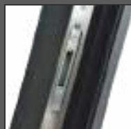
REGULACJA DOCISKU ZAMKA HAKOWEGO POMOCNICZEGO
