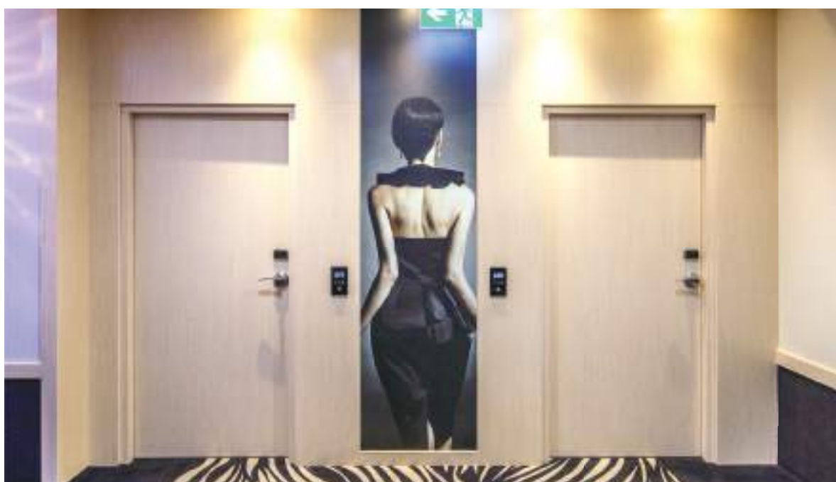
drzwi przeciwpożarowe FR EI30, ościeżnica stała drewniana
