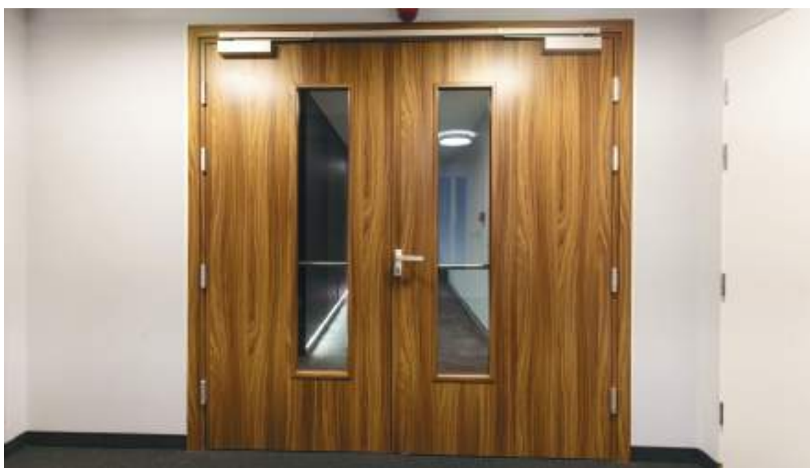
drzwi przeciwpożarowe FR EI30, ościeżnica stała drewniana
