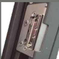
ELEKTROZACZEP ZAMONTOWANY W OŚCIEŻNICY TERMO ODS84
