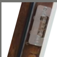
ELEKTROZACZEP ZAMONTOWANY W OŚCIEŻNICY TERMO ODS
