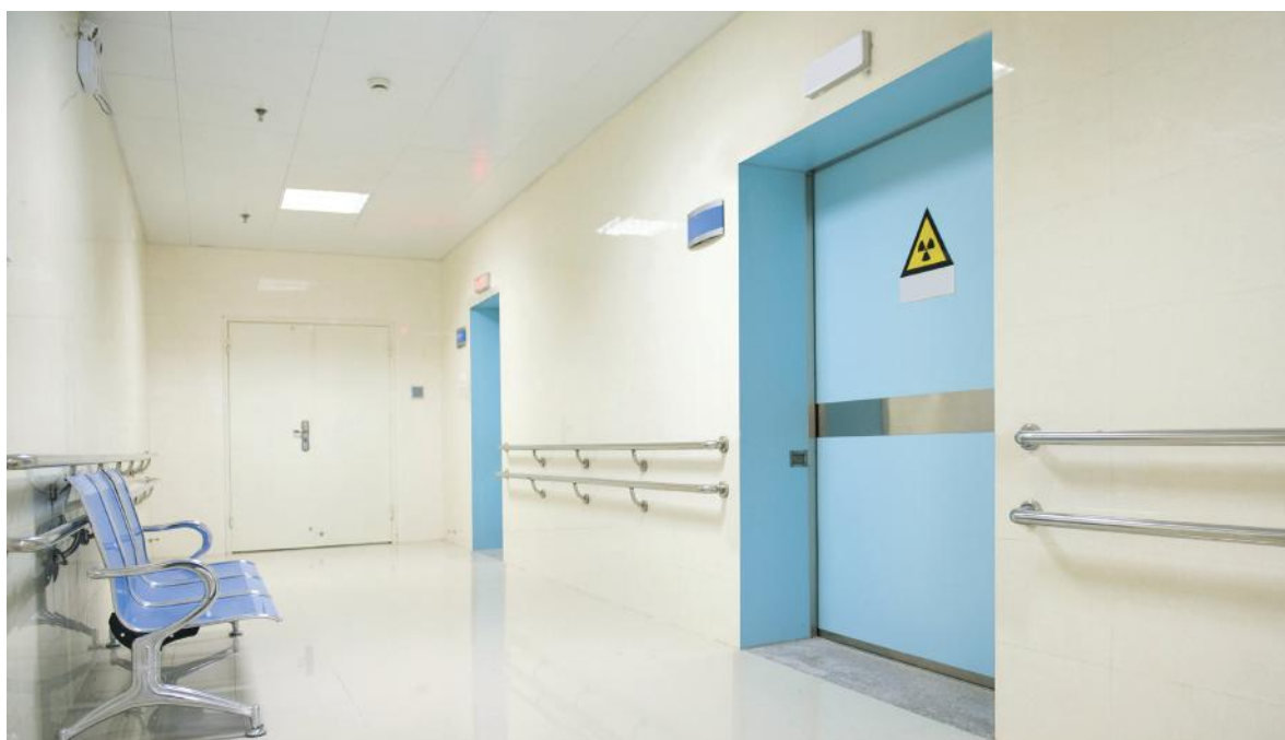
drzwi GAMMA, ościeżnica stała metalowa
