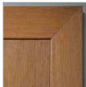
łączenie opasek pod kątem 45°
