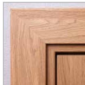
standardowe łączenie opasek pod kątem 45°
