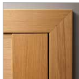
ościeżnica DIN DUO, opaski łączone pod kątem 45°
