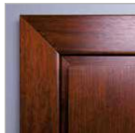
łączenie opasek pod kątem 45°
